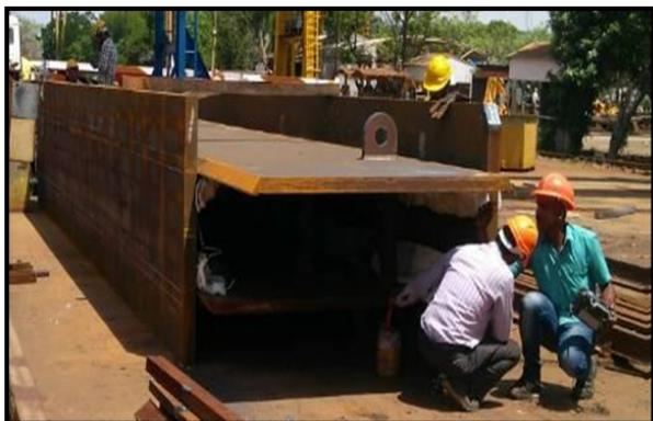
Fig. 1 : Box section fit- up
